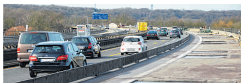
In Fahrtrichtung Duisburg laufen derzeit noch die Arbeiten für die Querkraftverstärkung an der Außenseite des maroden Bauwerks.
